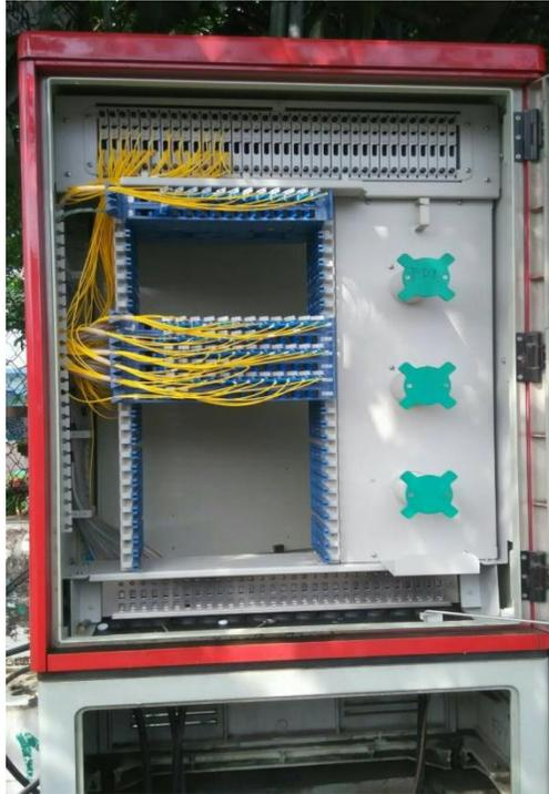
Gambar 3.8 ODC yang Sudah Diinstalasi
