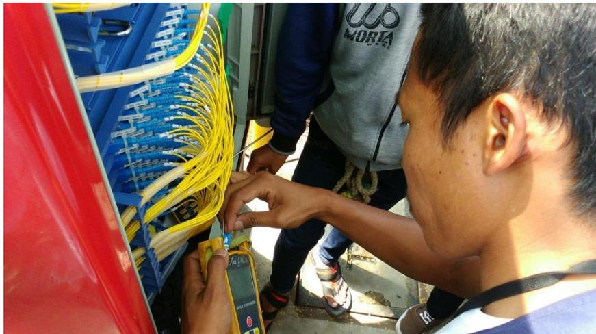
*Gambar 11 - Pengukuran Redaman Pada ODC (Uji Terima TITO INTI-Telkom)*
