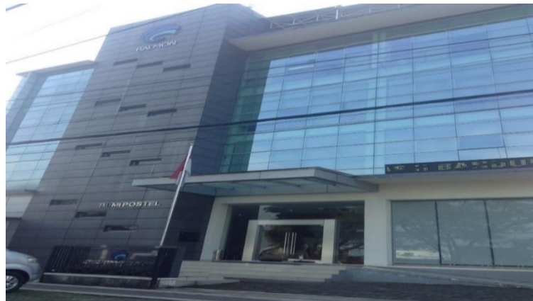
Gambar 2.3 Gedung Lokasi KP
