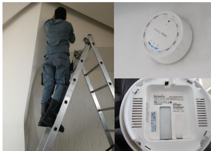
Gambar 3.19 Pencabutan Router yang menimbulkan gangguan
