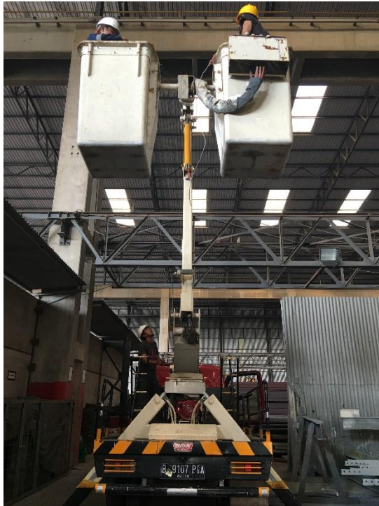
Gambar 3.34 Proses Pemasangan Menggunakan Truck Crane
