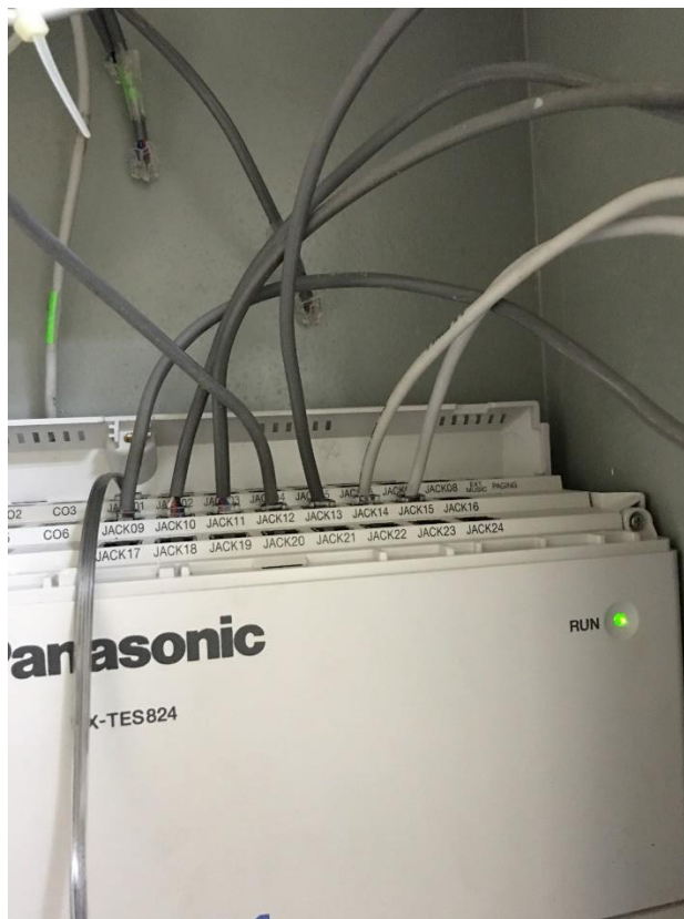
Gambar 3.40 Pemasangan Dan Penomoran Kabel RJ-11 Pada PABX
