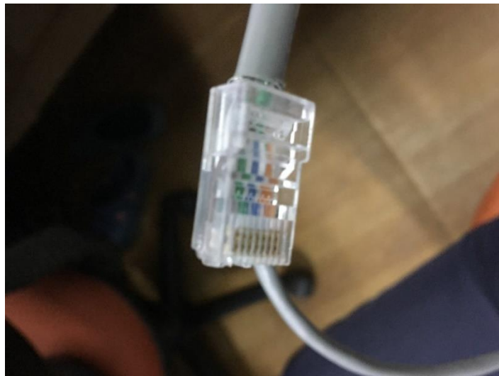
Gambar 3.11 Hasil Instalasai Kabel RJ-45 Konfigurasi Straight-through
