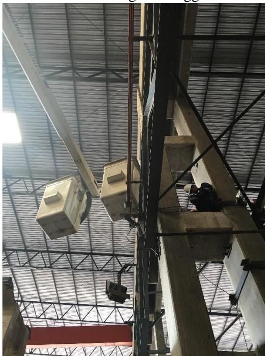
Gambar 3.35 Proses Pemasangan IP Camera (TelView)
