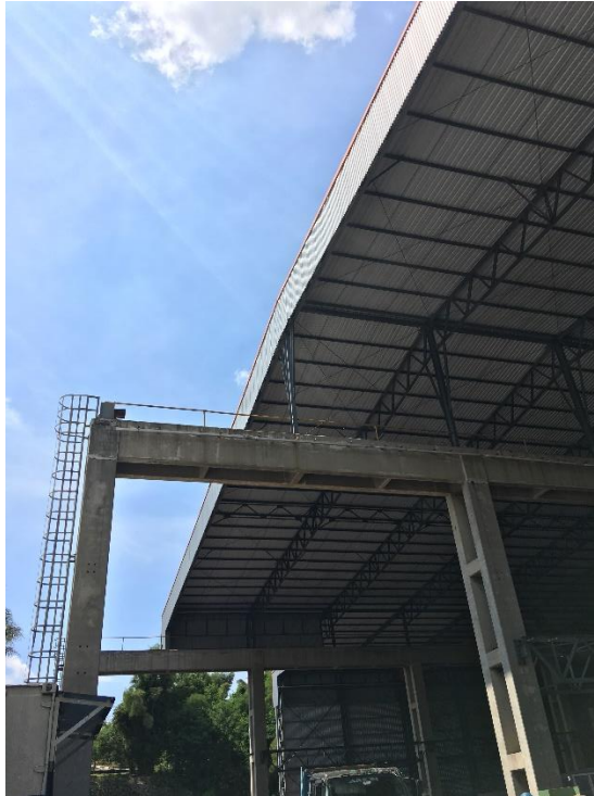
Gambar 3.32 Lokasi Pemasangan IP Camera (TelView)
