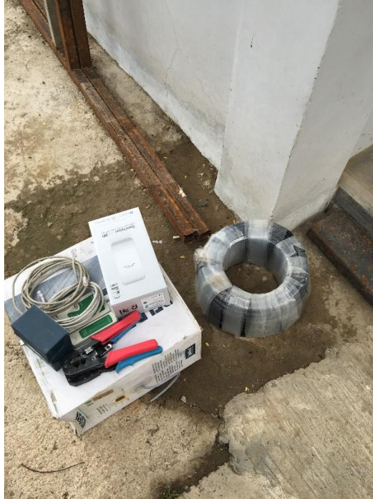
Gambar 3.19 Alat Dan Bahan Pemasangan Antena
