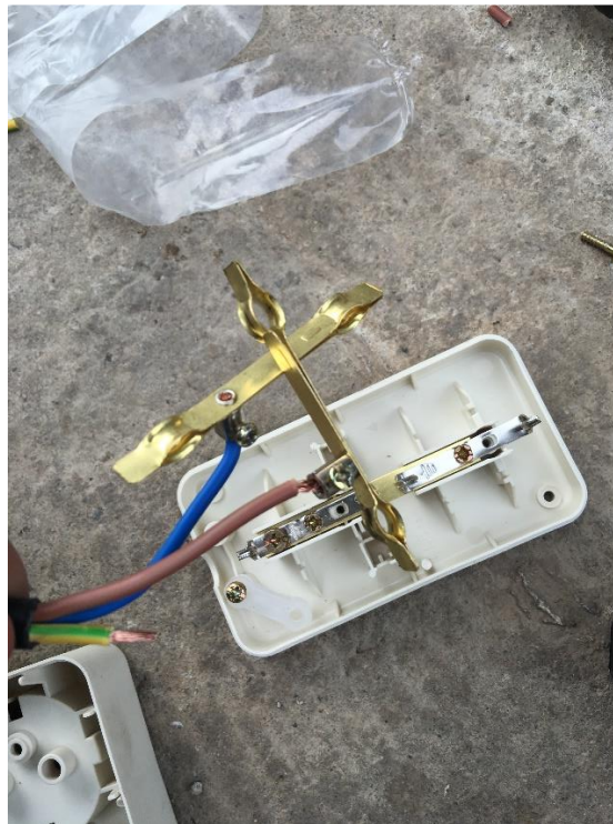
Gambar 3.25 Pemasangan Kabel Pada Stop Kontak
