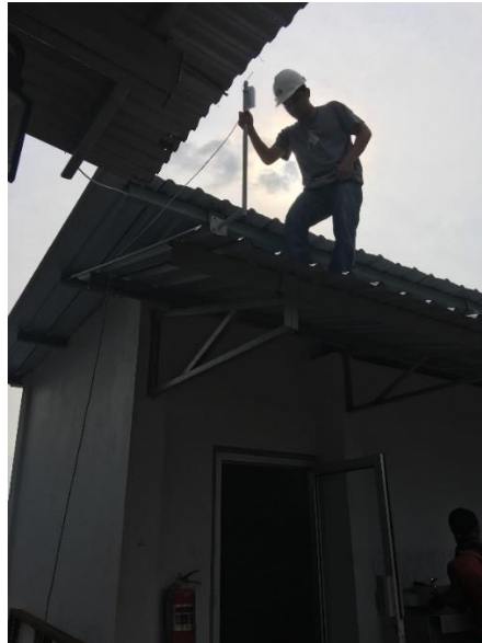
Gambar 3.28 Pemasangan Antena ( Nanostation Loco M5 )
