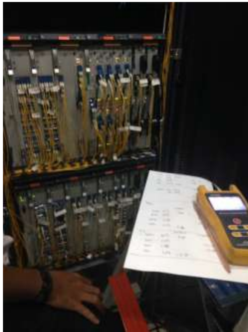
Gambar 3 6 Pengecekan Link menggunakan OTDR
