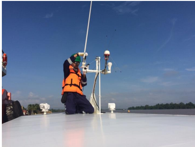
Gambar 3.6 Pemasangan antena fixed base pada seatruck
