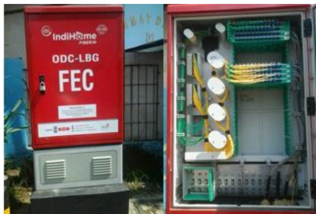
Gambar 16 - Kondisi ODC-FAW tidak ada kunci pengaman
