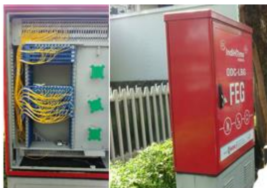
Gambar 17 - Kondisi ODC-FEC dengan kondisi baik
