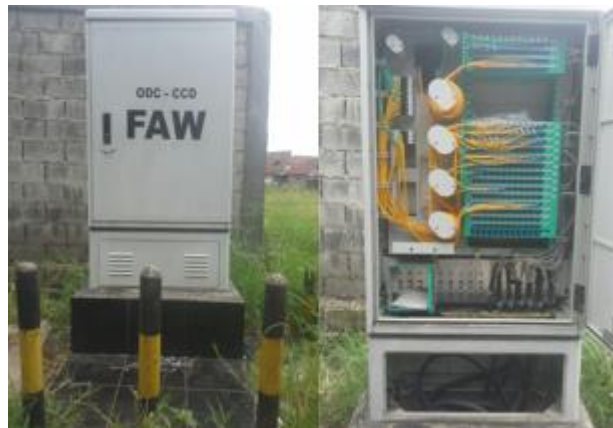
Gambar 16 - Kondisi ODC-FAW tidak ada kunci pengaman
