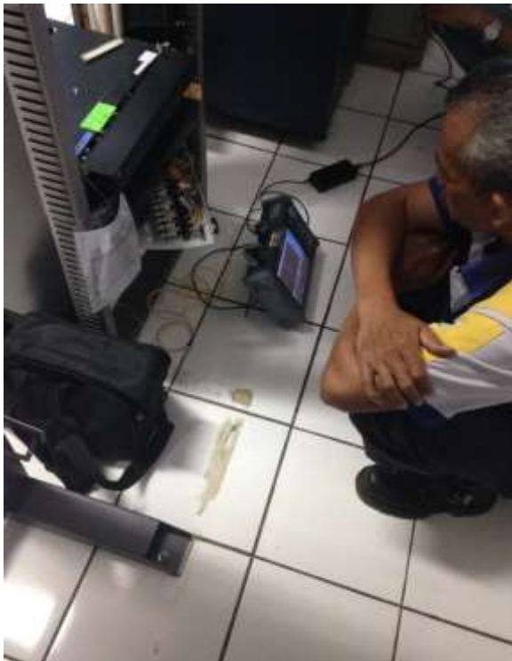
Gambar 3.14 Pemeriksaan gangguan link dengan OTDR
